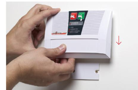
Навесить контроллер на пластину.
